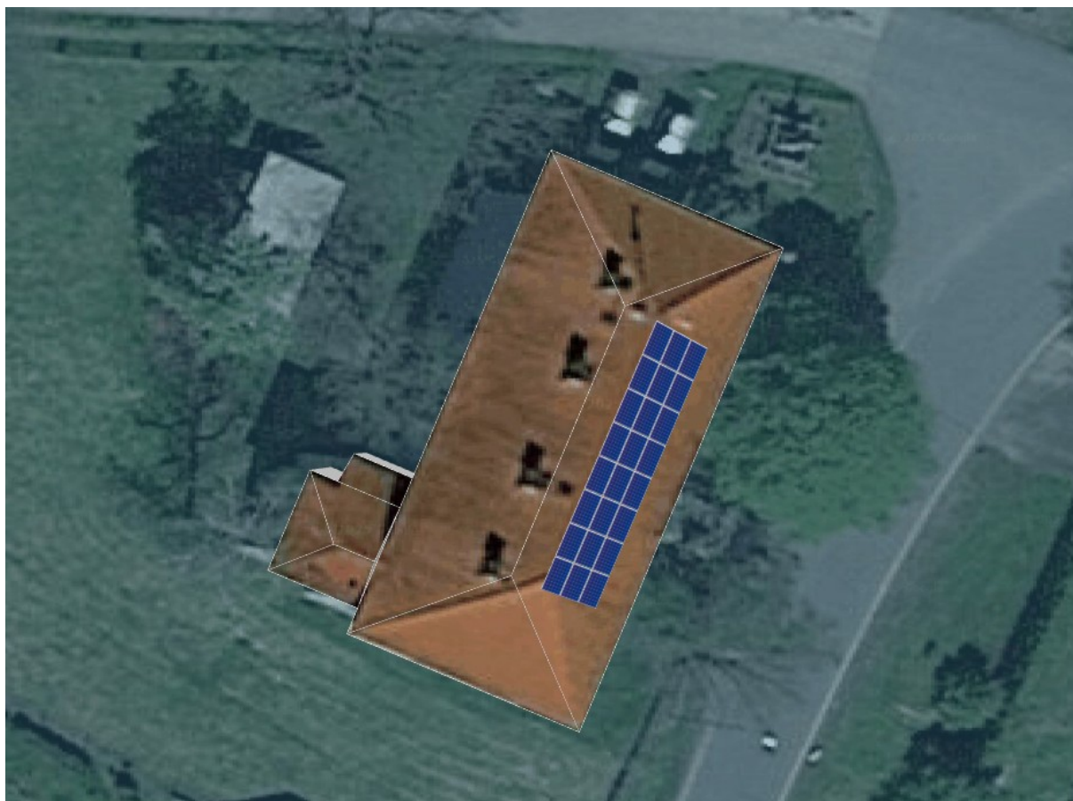
Obr. č. 36 - Umístění solárních panelů na obecním domě v Mlýnci
